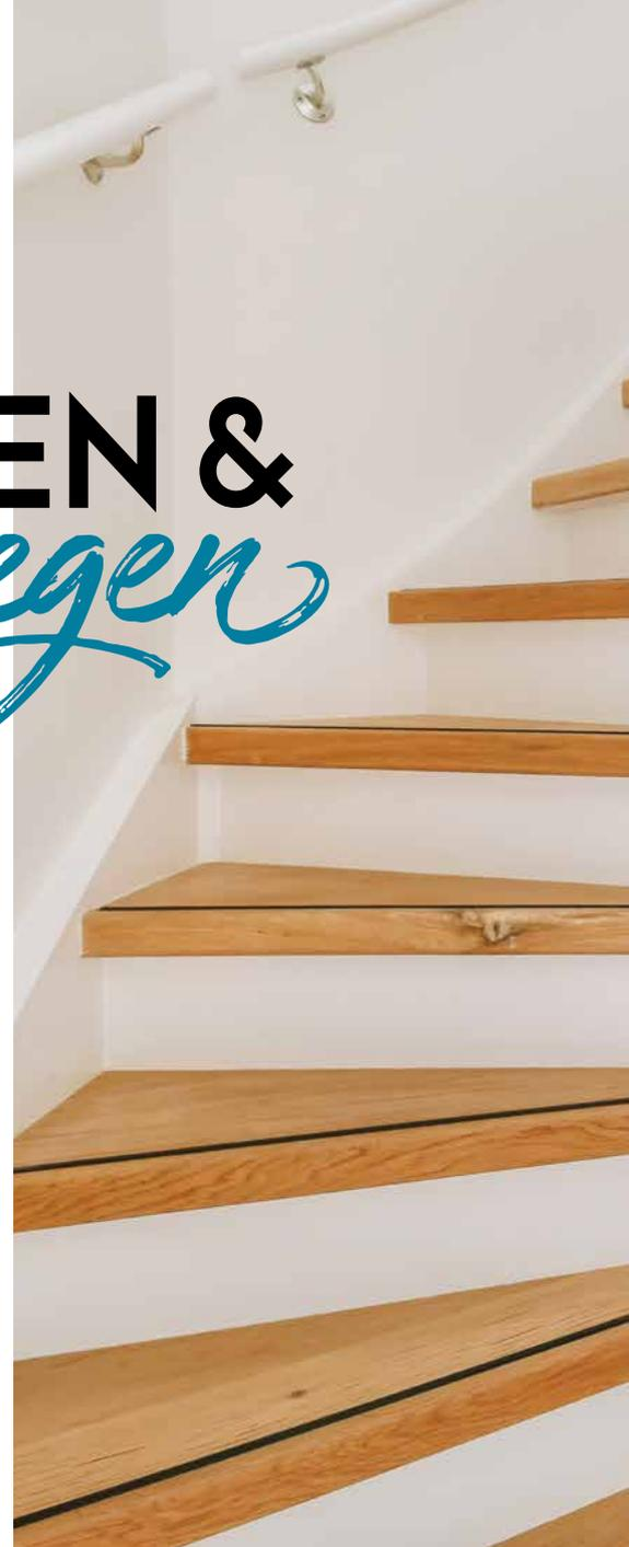
Während der Bauphase erfordert die freitragende Stiege ein Provisorium, das allerdings sehr kostengünstig aus Bauholz hergestellt wird. Dafür kann aber die freitragende Holzstiege spät angebracht werden, wodurch Beschädigungen oder auch das übermäßige Aufnehmen von Baufeuchtigkeit bedeutend eingeschränkt wird.
