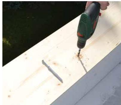
Die Unterlagsplatte kann direkt in das Attikamauerwerk befestigt werden. Fertig für die Verblechung.
