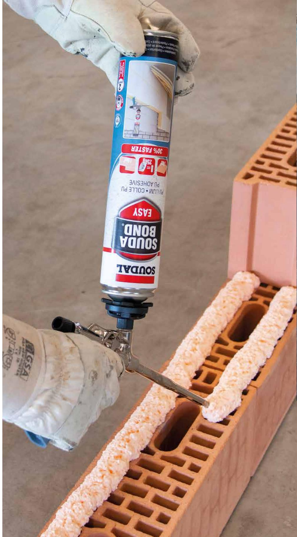
Auch der Einsatzbereich von Soudabond Easy ist vielseitig. Neben diversen Wärmedämmungen z. B. für Kellerdecken, Dachboden oder Wände können damit auch nichttragende Innenwände aus Ziegeln verklebt werden. Soll eine Wand verschönert werden? Kein Problem, mit Soudabond
